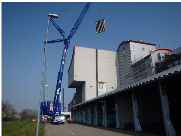
Anheben eines Ersatz-Überhitzerbündels
